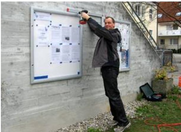
Gerd Maier bei der Montage des neuen Schaukastens
